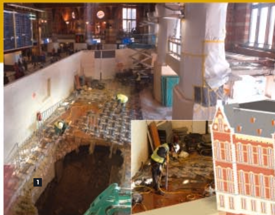
Na jaren van voorbereidende werkzaamheden, is met het begin van de sloop van de vloer in de monumentale stationshal afgelopen februari, de verbouwing van het Centraal Station echt begonnen.
