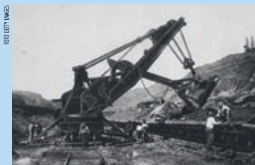
Een stoomgedreven graafmachine tijdens de aanleg van het Panamakanaal in 1906.
