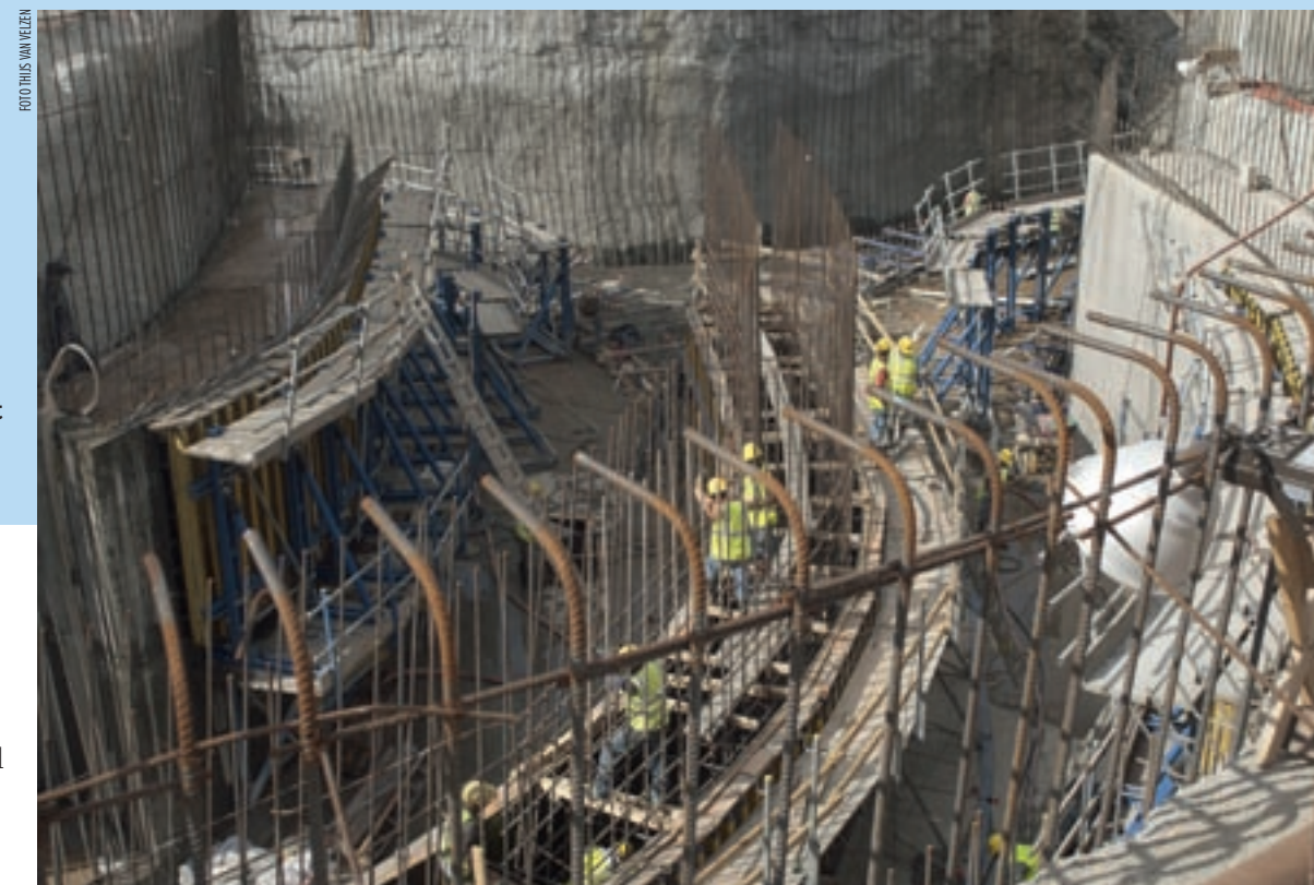
Het risico op aardbevingen vertaalt zich in zware wapening van het beton in de sluiscomplexen.
