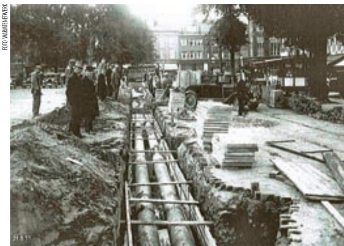
De eerste warmteleiding in Nederland stamt uit 1923 en liep van de kolencentrale aan de Nicolaas Beetsstraat in Utrecht naar het ziekenhuis aan de Catherijnesingel.
