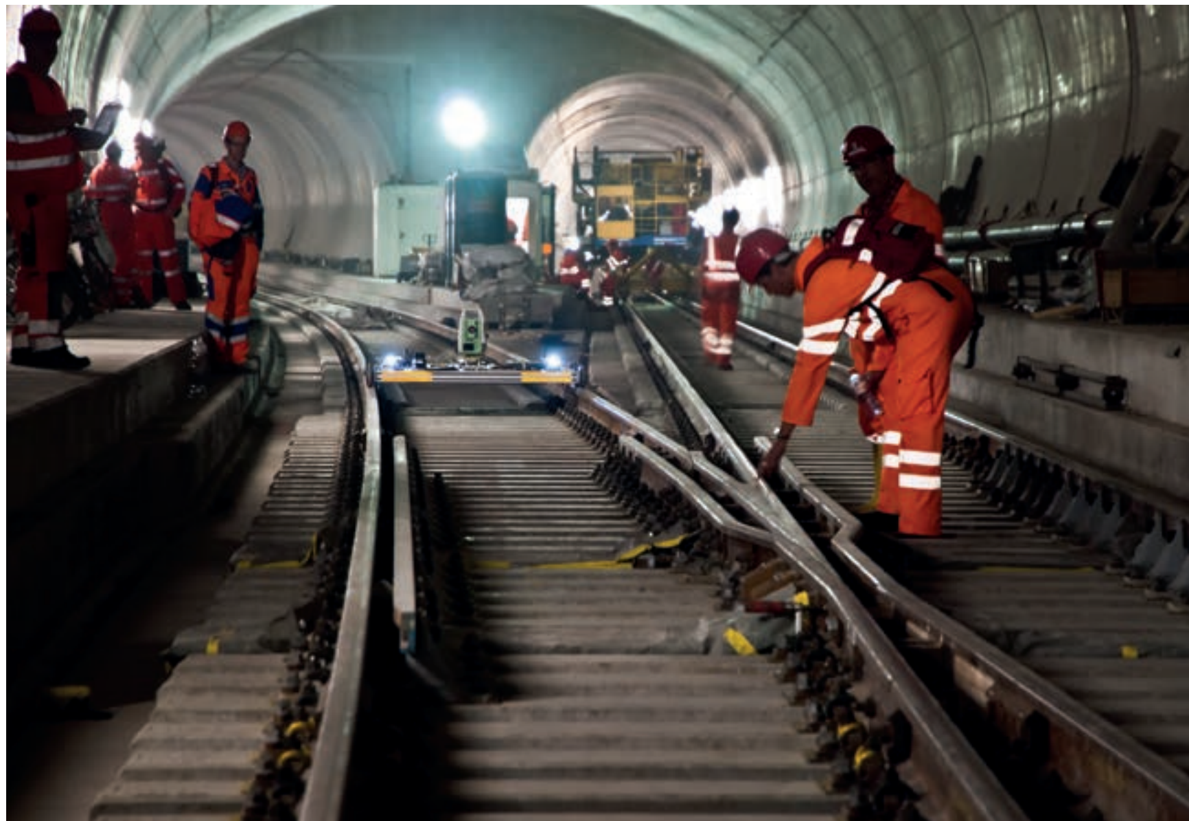
Controle van de nieuw aangelegde rails met een meetwagen.
