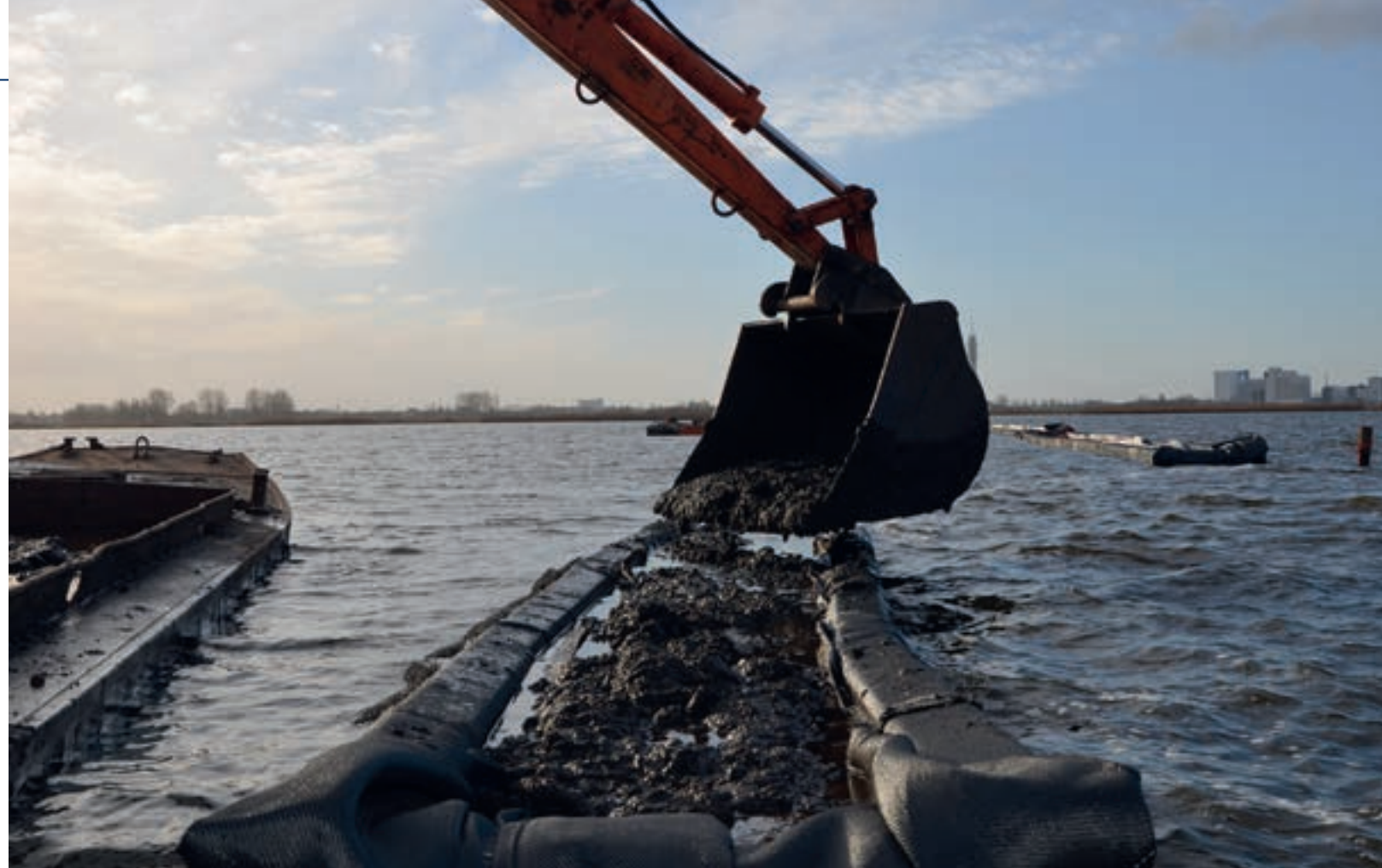
Het vullen van de slibremmer met bagger.
