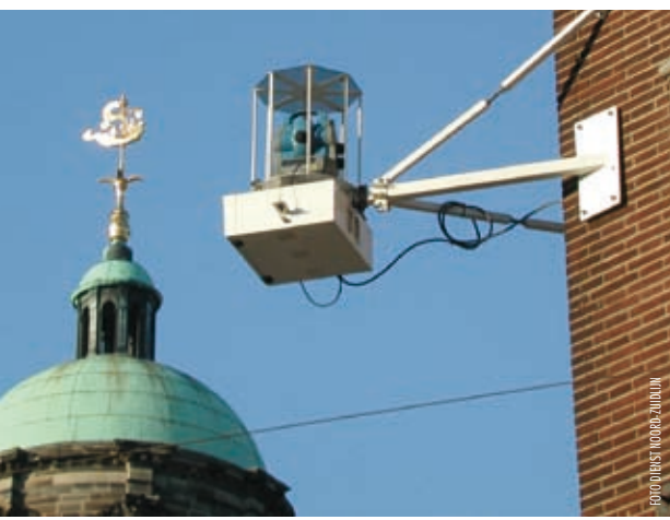
Speciale meetstations langs het tracé moeten zettingen registreren.
