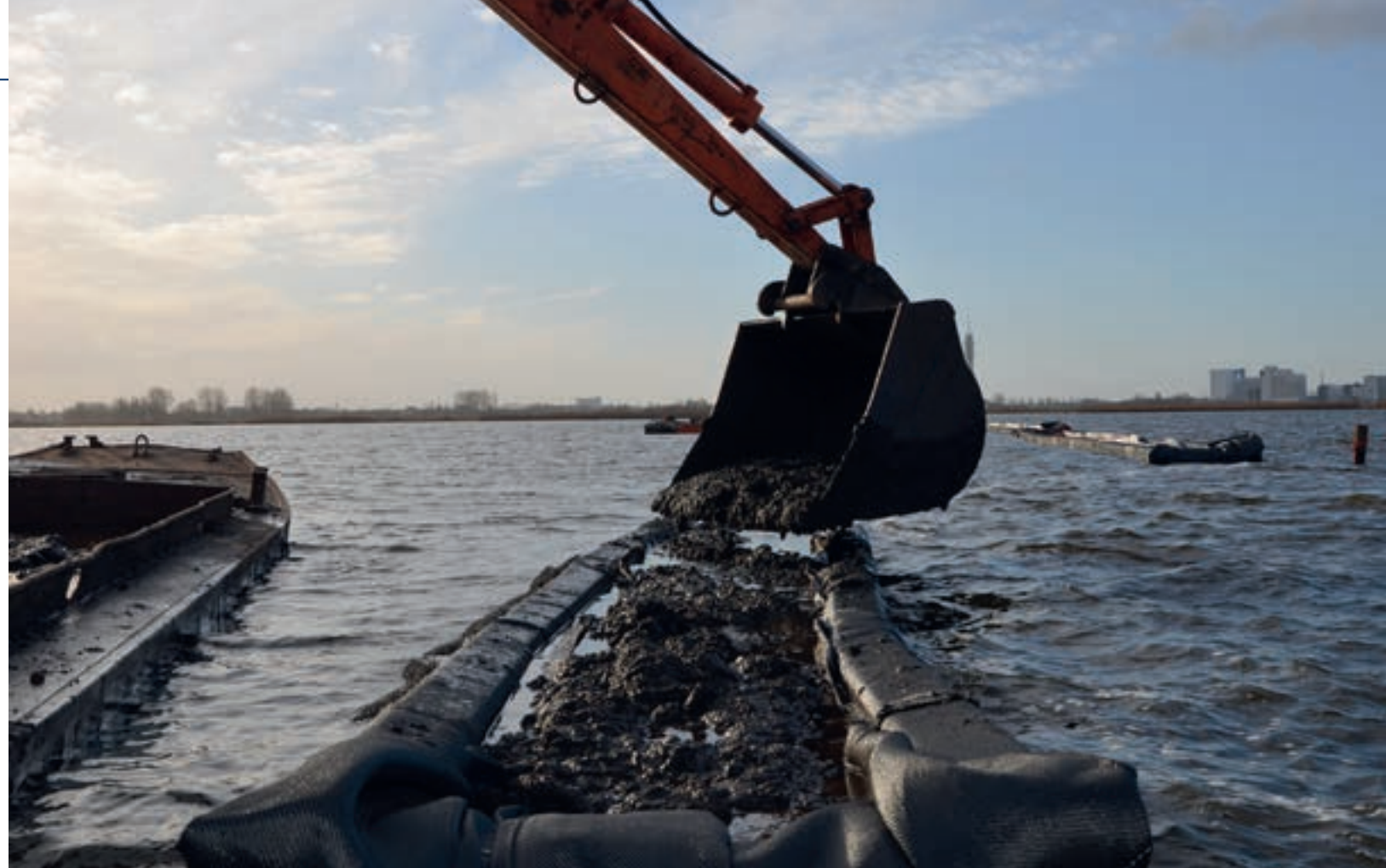
Het vullen van de slibremmer met bagger.
