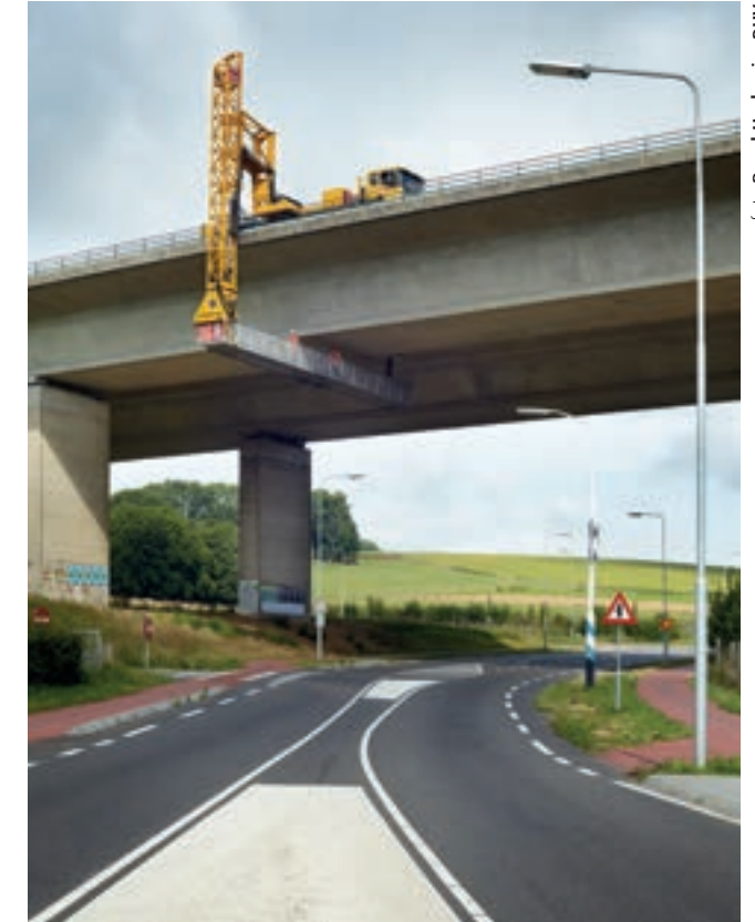
Inspectie van de betonnen fly-over van de A73 bij Valkenburg.
